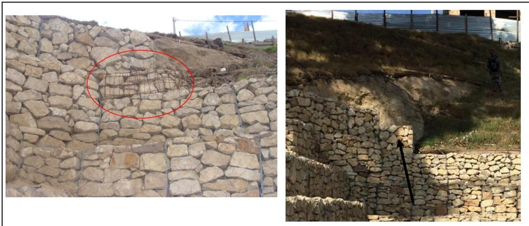
**Fotografías No. 9.** Unidad de gavión que presentaba deficiencias en la construcción (Octubre de 2014) y que fue reemplazado (Febrero de 2015)
