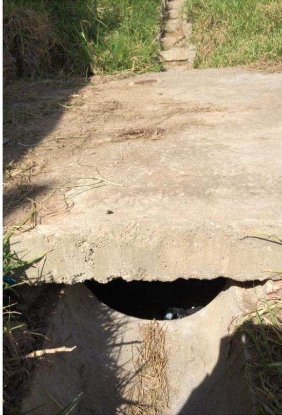
**Fotografía No. 15.** Detalle de canales perimetrales y cajas disipadoras de energía y desarenadora.
