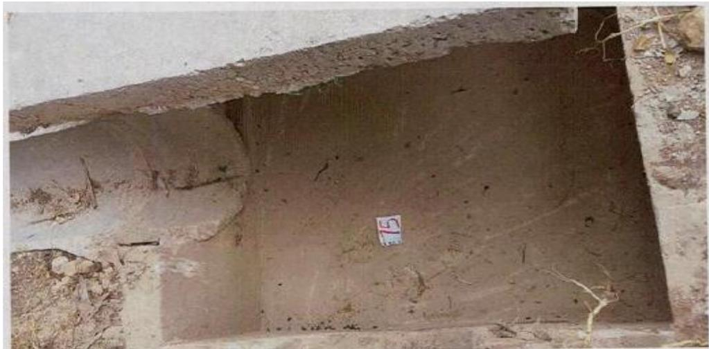
**Fotografía No. 14.** Detalle de una de las cajas disipadoras de energía y desarenadora con adecuado estado de mantenimiento. Véase la salida hacia la cuneta en media caña.
