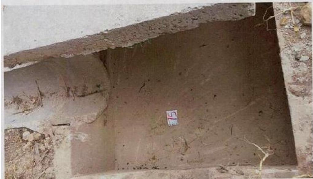
**Fotografía No. 14.** *Detalle de una de las cajas disipadoras de energía y desarenadora con adecuado estado de mantenimiento. Véase la salida hacia la cuneta en media caña.*
