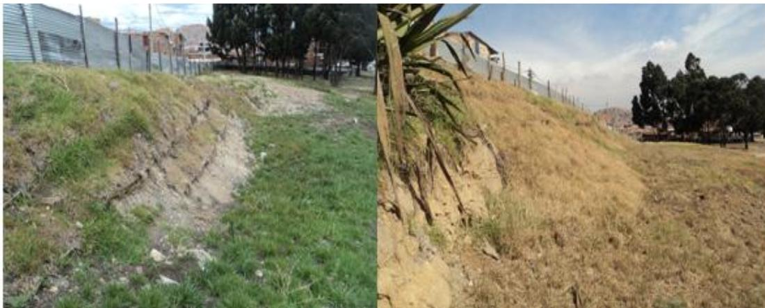
**Fotografía No. 2. Áreas empradizadas.** La foto ubicada a la izquierda fue tomada en octubre de 2014 y la ubicada a margen derecha en febrero de 2015, se evidencia el proceso de empradización, realizando acciones correctivos en lo referente a la estabilización de los taludes
