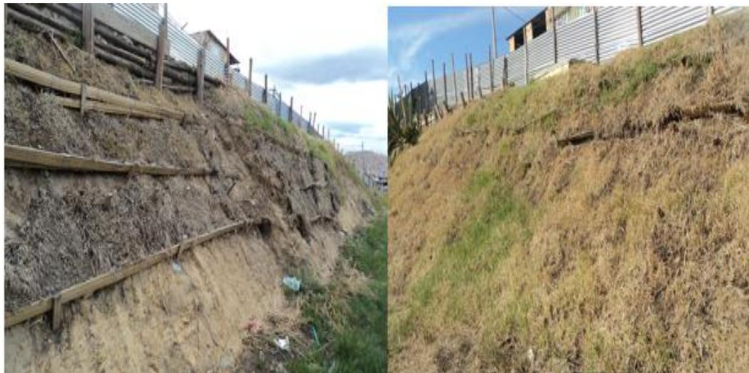
**Fotografía No. 6. Taludes empradizados.** En Octubre de 20104, se evidenciaba que el método de los trinchos no estaba siendo eficaces en el establecimiento de la cobertura vegetal. En Febrero de 2015, se evidencia el establecimiento de la cobertura vegetal sobre los taludes
