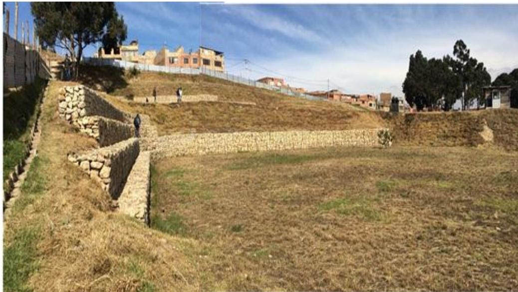
**Fotografía No. 8.** Vista general de la zona de ubicación de las obras geotécnicas del PMRRA –Véase el relleno en la parte posterior de los gaviones.
