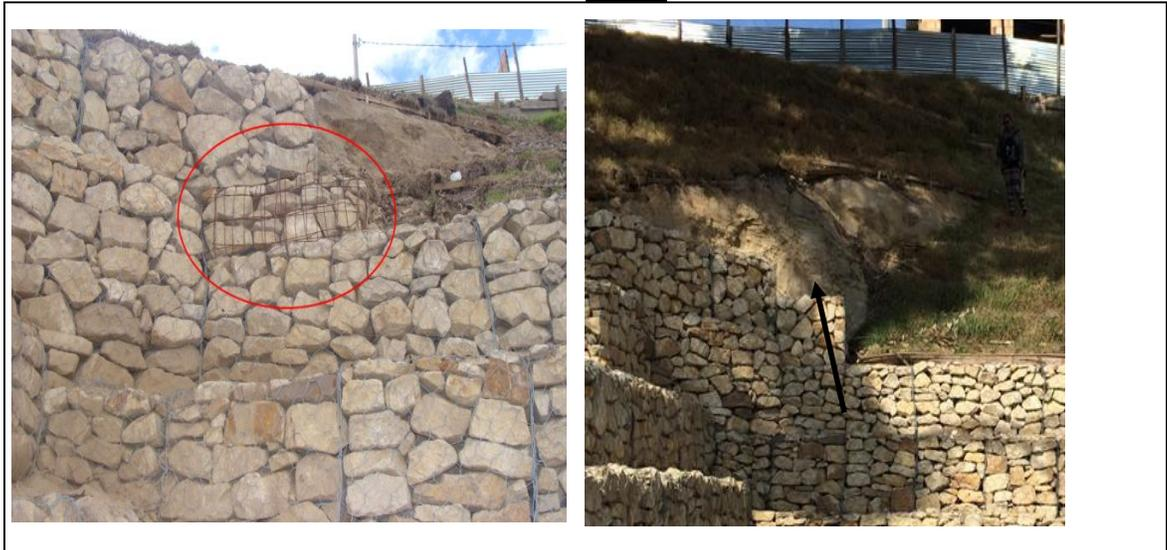
**Fotografías No. 9.** Unidad de gavión que presentaba deficiencias en la construcción (Octubre de 2014) y que fue reemplazado (Febrero de 2015)
