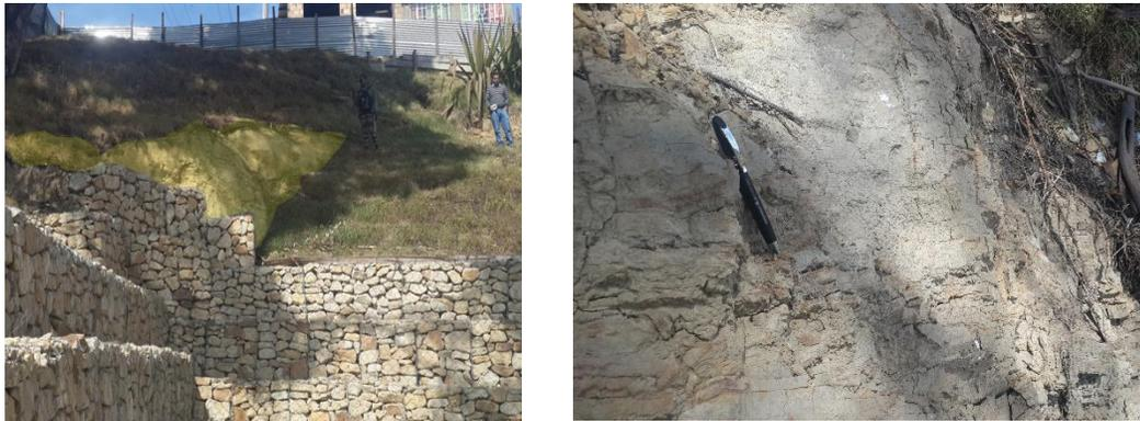
**Fotografía No. 7. Localización de un corte realizado como parte de la adecuación morfológica y estabilización de la ladera en el costado sur del predio. En caso de no realizarse mantenimiento integral de las obras hídricas y de estabilización, se pueden generar en un futuro procesos erosivos que pueden contribuir a la ocurrencia de movimientos en masa. Visual foto SW-NE.**
