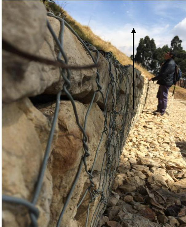
**Fotografía No. 13.** Detalle de la leve inclinación (cabeceo) del segundo nivel del muro en gabión costado sur. Estas inclinaciones mínimas son normales en la etapa inicial de funcionamiento de una estructura de contención y aunque ésta leve inclinación no compromete la estabilidad de la estructura, se recomienda realizar un monitoreo específico a dicho cabeceo, de tal manera que se puedan implementar medidas correctivas en caso de que el mismo sea progresivo.
