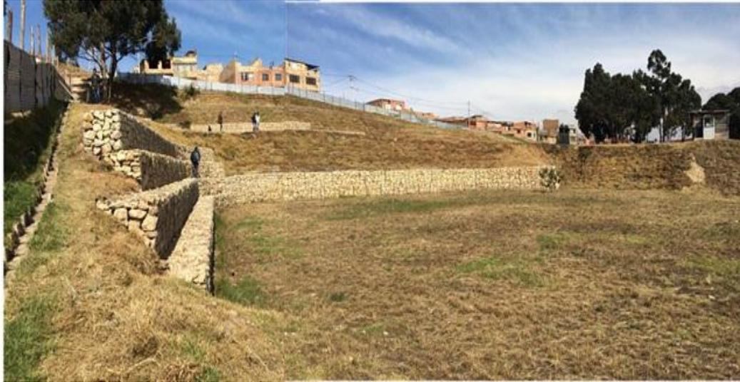
**Fotografía No. 8.** Vista general de la zona de ubicación de las obras geotécnicas del PMRRA –Véase el relleno en la parte posterior de los gaviones.
