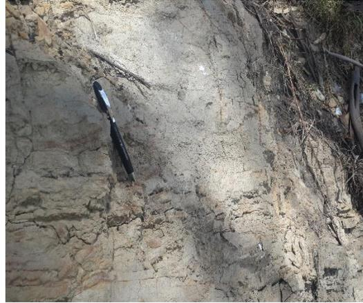
**Fotografía No. 7.** Localización de un corte realizado como parte de la adecuación morfológica y estabilización de la ladera en el costado sur del predio. En caso de no realizarse mantenimiento integral de las obras hídricas y de estabilización, se pueden generar en un futuro procesos erosivos que pueden contribuir a la ocurrencia de movimientos en masa. Visual foto SW-NE.
