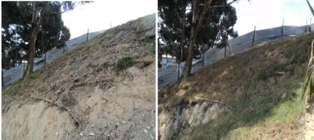
**Fotografía No.3. Áreas empradizadas.** La foto ubicada a la izquierda fue tomada en octubre de 2014 y la ubicada a margen derecha en febrero de 2015, se evidencia el proceso de empradización, realizando acciones correctivos en lo referente a la estabilización de los taludes y el prendimiento de los cespedones
