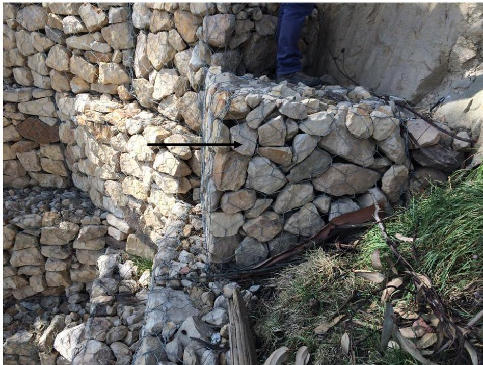
**Fotografía No. 10.** Detalle de la unidad de gavión que reemplazo en anterior por deficiencias técnicas
