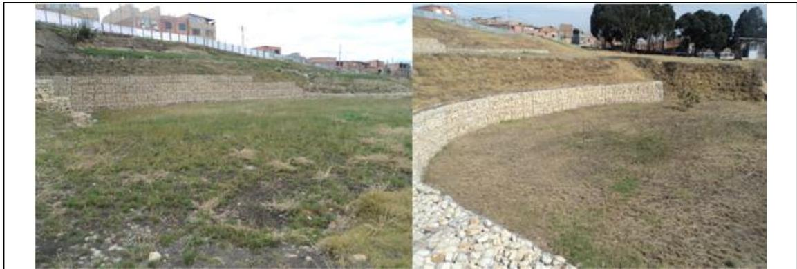
**Fotografía No. 4. Áreas empradizadas.** La foto ubicada a la izquierda fue tomada en octubre de 2014 y la ubicada a margen derecha en febrero de 2015, se evidencia el proceso de empradización en los taludes reconformado.
