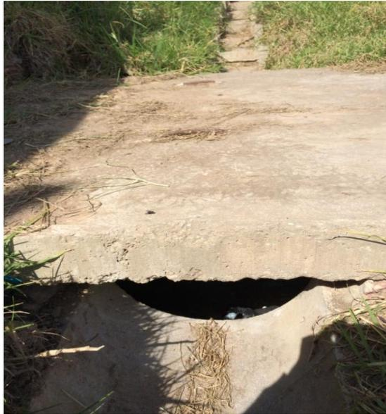
**Fotografía No. 15.** *Detalle de canales perimetrales y cajas disipadoras de energía y desarenadora.*
