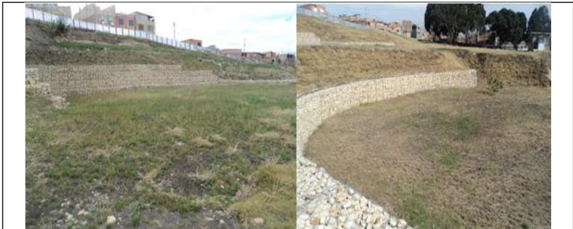
**Fotografía No. 4. Áreas empradizadas.** La foto ubicada a la izquierda fue tomada en octubre de 2014 y la ubicada a margen derecha en febrero de 2015, se evidencia el proceso de empradización en los taludes reconformado.
