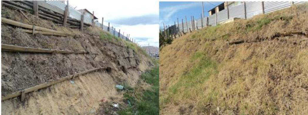
**Fotografía No. 6. Taludes empradizados.** En Octubre de 20104, se evidenciaba que el método de los trinchos no estaba siendo eficaces en el establecimiento de la cobertura vegetal. En Febrero de 2015, se evidencia el establecimiento de la cobertura vegetal sobre los taludes
