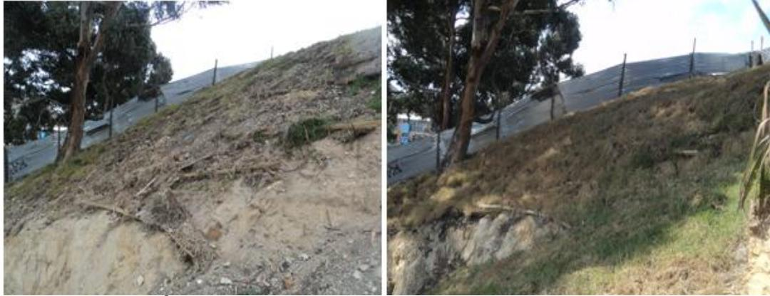
**Fotografía No.3. Áreas empradizadas.** La foto ubicada a la izquierda fue tomada en octubre de 2014 y la ubicada a margen derecha en febrero de 2015, se evidencia el proceso de empradización, realizando acciones correctivos en lo referente a la estabilización de los taludes y el prendimiento de los cespedones
