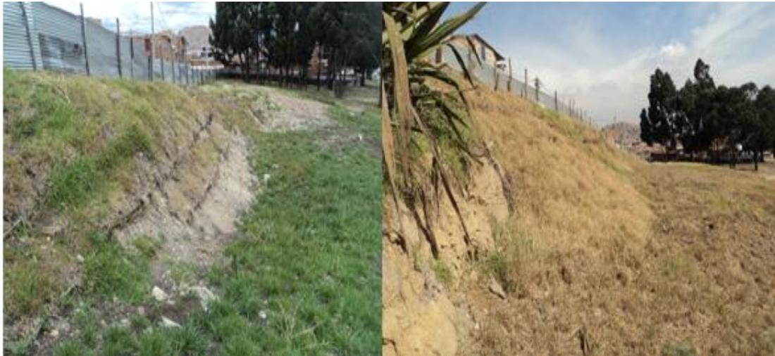
**Fotografía No. 2. Áreas empradizadas.** La foto ubicada a la izquierda fue tomada en octubre de 2014 y la ubicada a margen derecha en febrero de 2015, se evidencia el proceso de empradización, realizando acciones correctivos en lo referente a la estabilización de los taludes
