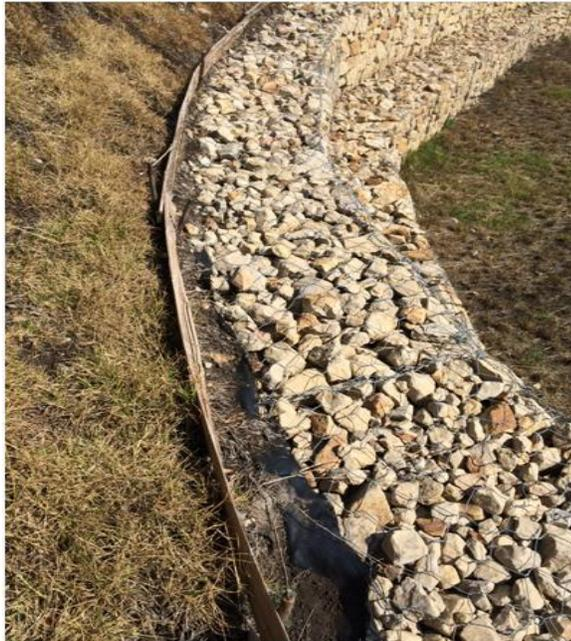
**Fotografía No. 11.** Evidencia del retiro de material arcilloso en el muro de gaviones costado sur
